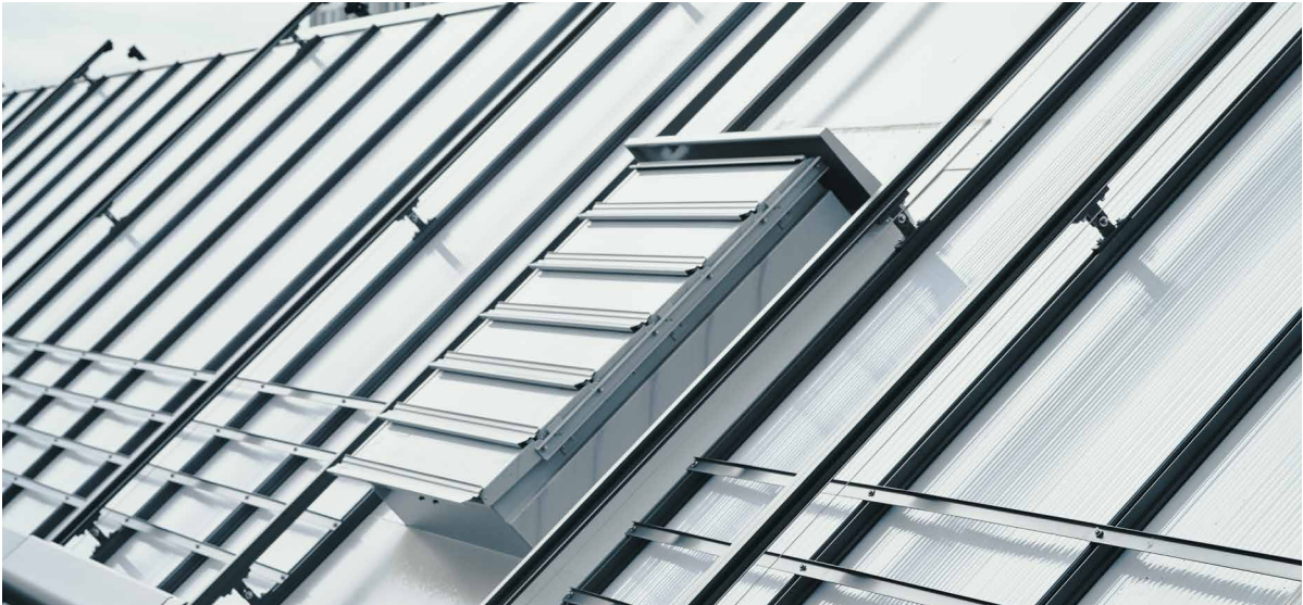
Carlswerk | Köln Lyra-vent_L2 ins Satteldachlichtband integriert
