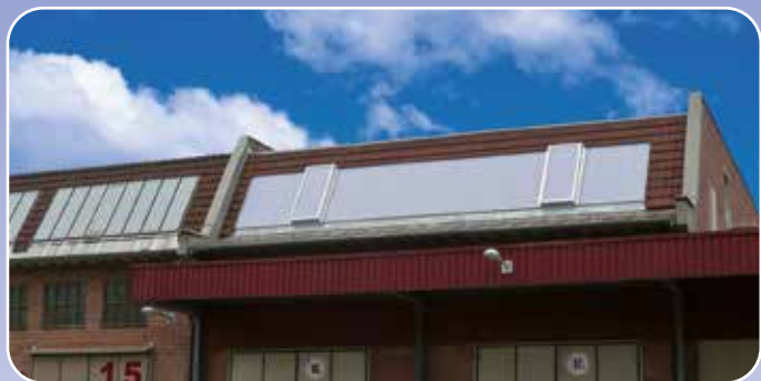
Sanierung - vorher - nachher
