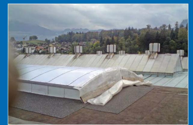
VORHER Ausgangssituation: Industriehalle mit bestehendem Satteldachlichtband mit Dunkelfeldern, Drahtglas und Permanentlüftern.
