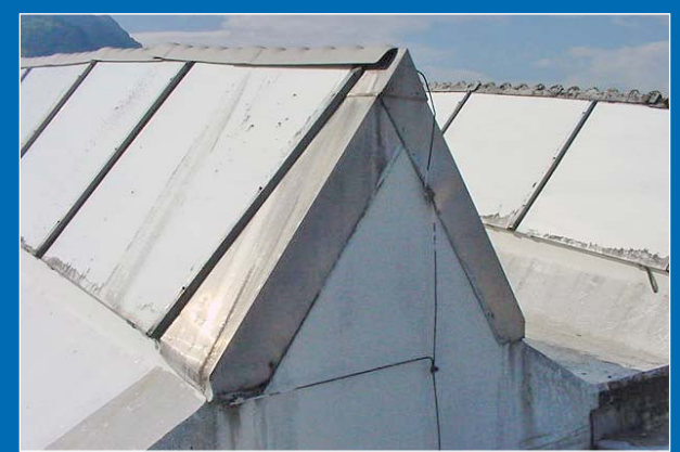
VORHER Ausgangssituation: Industriehalle mit bestehendem Satteldachlichtband mit Dunkelfeldern und Wellplatten.
