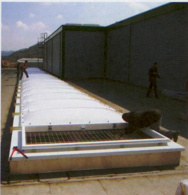
Eine Gittereinlage unterhalb des Oberlichts dient als Absturzsicherung.
