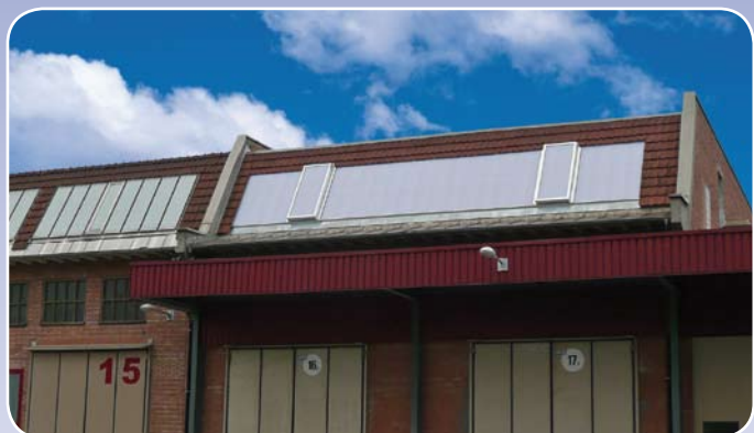
Sanierung - vorher - nachher
