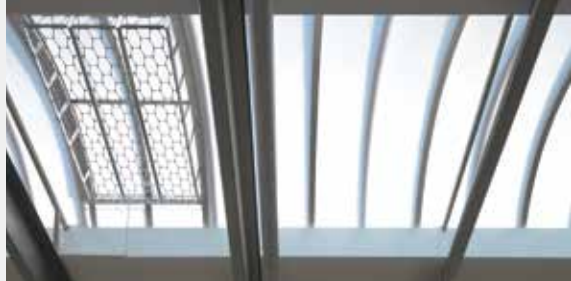
Bild 2.0 Innenansicht Lichtband: DHSS_W Lichtbandklappe DSS_A mit Lüftungsfunktion
